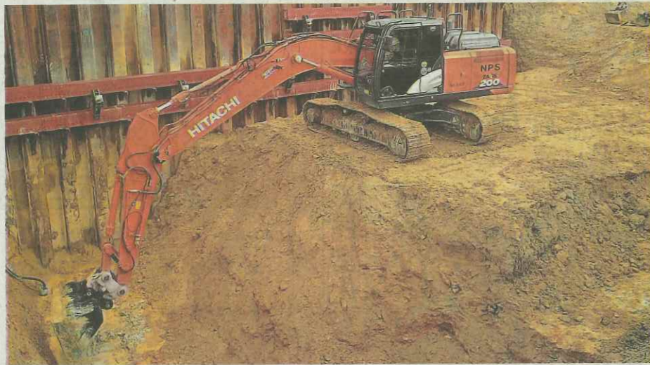
センサーでバケットの位置を把握して、正確な掘削を行うバックホウと運転席に設置されたモニターで掘削勾配を確認。中津川市加子母、濃飛横断自動車道(仮称)濃飛3号橋橋梁下部工事現場
